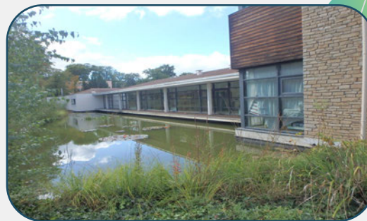
Bassin en eau
