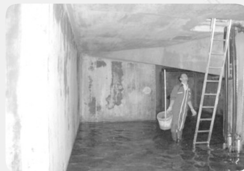
Espace confiné : équipements de protection obligatoires
